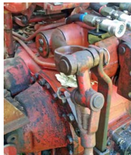
Denna gång är det packboxen på vänster sida som läcker. På bilden syns lyftarmen och de 2 skruvar som håller lyftarmen på plats.
