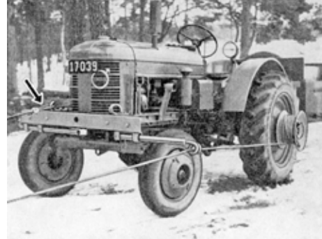
3. Hjulvinsch 801 är ett av många exempel på speciell utrustning för militärt bruk.
