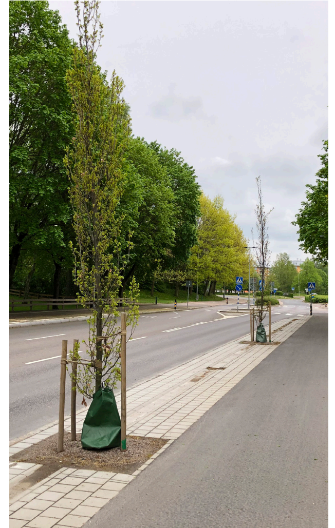
▲ Tree trench on a strip of open subbase layer. Liedbergsgatan, Växjö.
