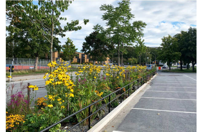
▲ Vegetation areas over a strip of open subbase layer. Eksättravägen, Stockholm.
