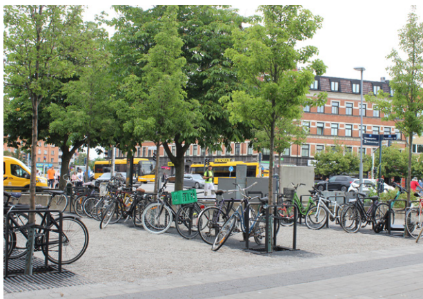
▲ Parkoviště pro kola s propustnou dlažbou nad podzemní rýhou s otevřeným podkladem, která plní funkci podzemní retenční nádrže pro dešťovou vodu a prokořenitelného prostoru pro zeleň. Södervärn, Malmö.
