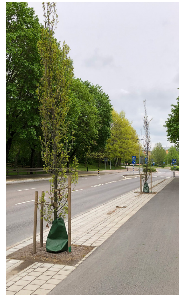
▲ Stromy ve zpevněné ploše nad pásem podzemní rýhy s otevřeným podkladem. Liedbergsgatan, Växjö.
