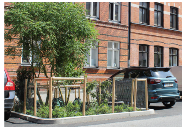
▲ Parkovací místa, průlehy nad pásem podzemní rýhy s otevřeným podkladem. Ängelholmsgatan, Malmö.
