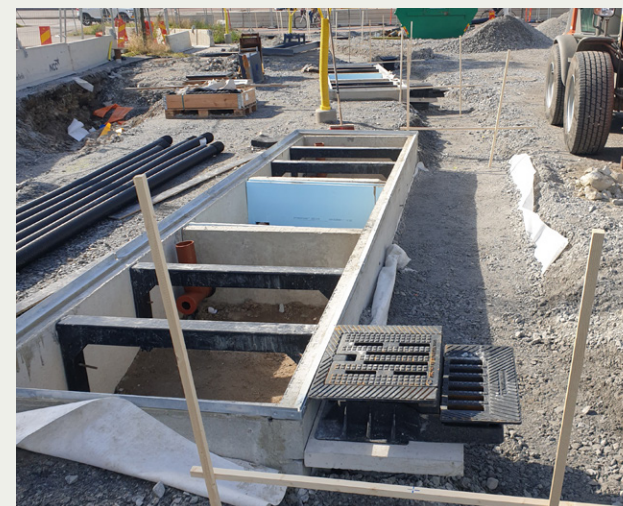
▲ Během stavby zakrytého průlehu. Nacka. Foto: Agata Wehlin.
