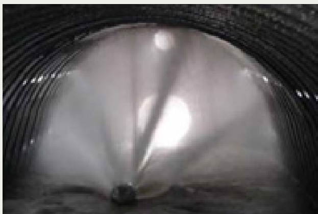
▲ Vyplachování vsakovacího tunelu pro odstranění sedimentu.
