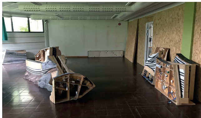
De første anleggsseksjonen på plass på Ringve bak nyoppsatt vegg.
