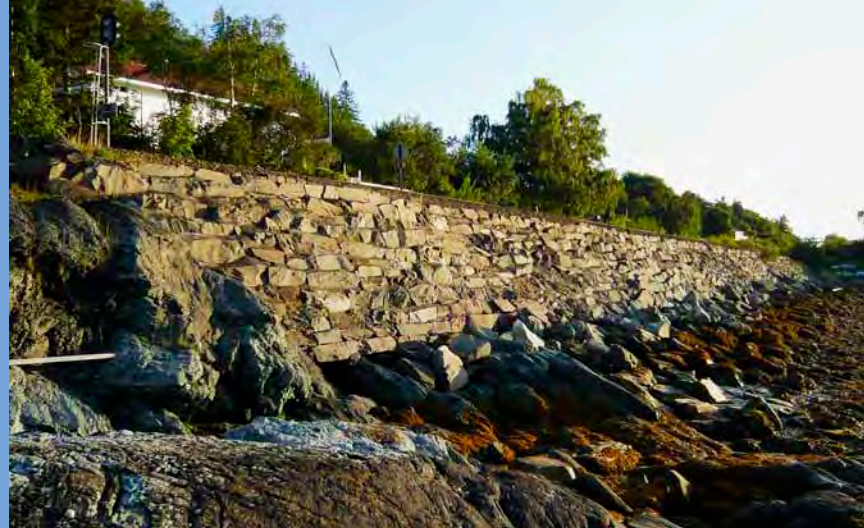
Bratt tørrsteinsmur ved Hundhamaren, nærmere Trondheim. Langs Ørskfjorden bygger vi slike, med steinete fjære foran, ned mot sjøen.
