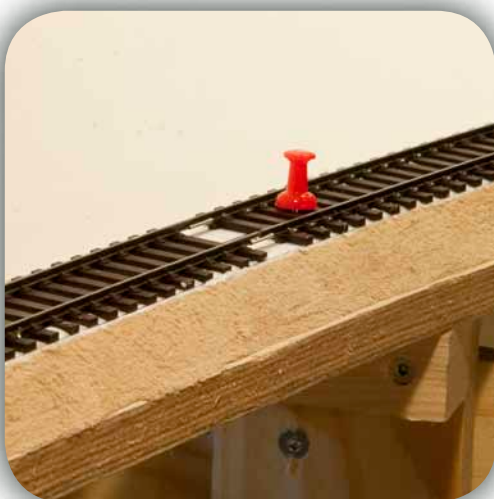
11. SPORET ER FERDIG LAGT: Det blir et opphold i svillematten i skjøten, der det må legges sviller.
