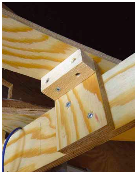
Underlagsstøtter: T.v Sporunderlag, støtte og skrufeste, t.h skrufeste på ende av seksjon.
