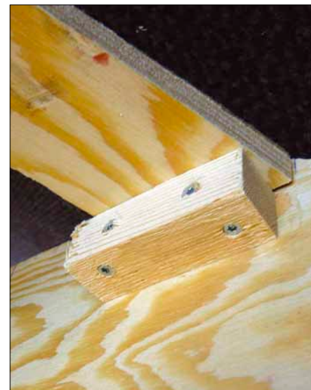
Underlagsstøtter: T.v Sporunderlag, støtte og skrufeste, t.h skrufeste på ende av seksjon.
