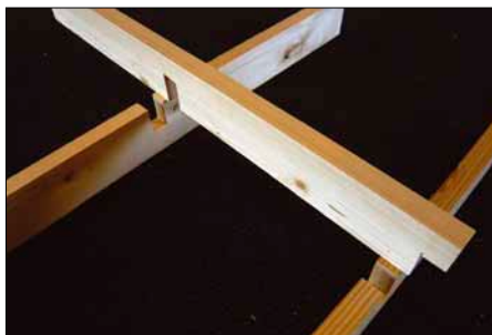
Sammenføyninger: Seksjonsdelene tappes ut og føyes sammen som vist. Først et sagsnitt på hver side, og så tappjern for å løsne trebiten. Vi bruker en drasag av japansk type til dette.
