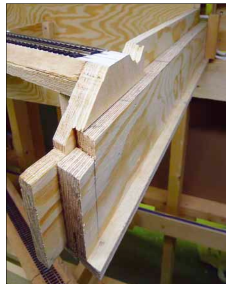
Nivå 2: Seksjonene på nivå 2 er lagt opp på utragende t-profiler, slik fotoene over viser.
