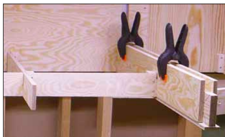
Nivå 2: Seksjonene på nivå 2 er lagt opp på utragende t-profiler, slik fotoene over viser.
