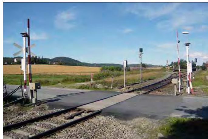
TROVERDIGHET: Installasjonene underveis må være korrekte. Planoverganger, signaler, relehus, kabelkulverter ... alt må stemme.
