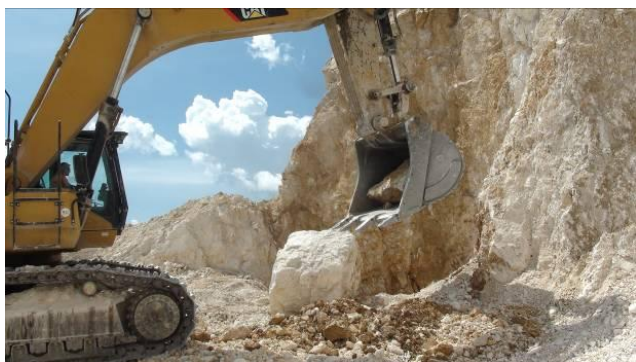
Des blocs sont positionnés au bord du gouffre.
