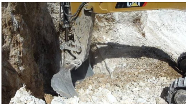
Nettoyage de l'entrée à la pelle mécanique.
