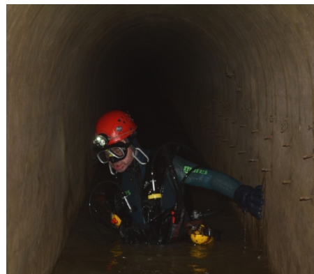
Plongée de Dédé à Suarlée : descente par la cheminée d'aération et sortie dans la longue galerie du fort.
