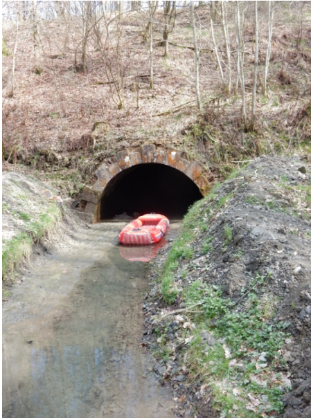
Le canal souterrain.
