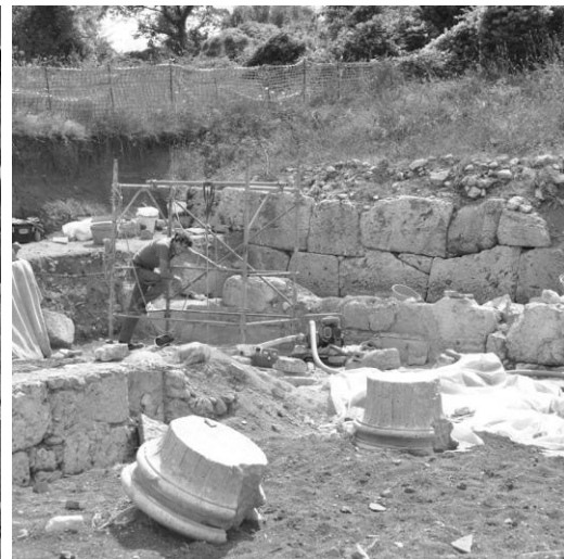
Fig. 9. Fouille du puits à l'arrière de la Salle aux Marbres en 2010. Photo © ULB - MRAH.
