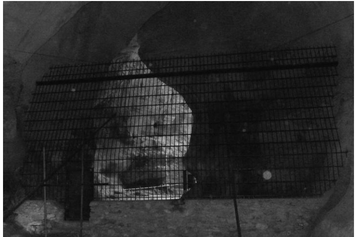
La grande grille de la galerie d'entrée.
