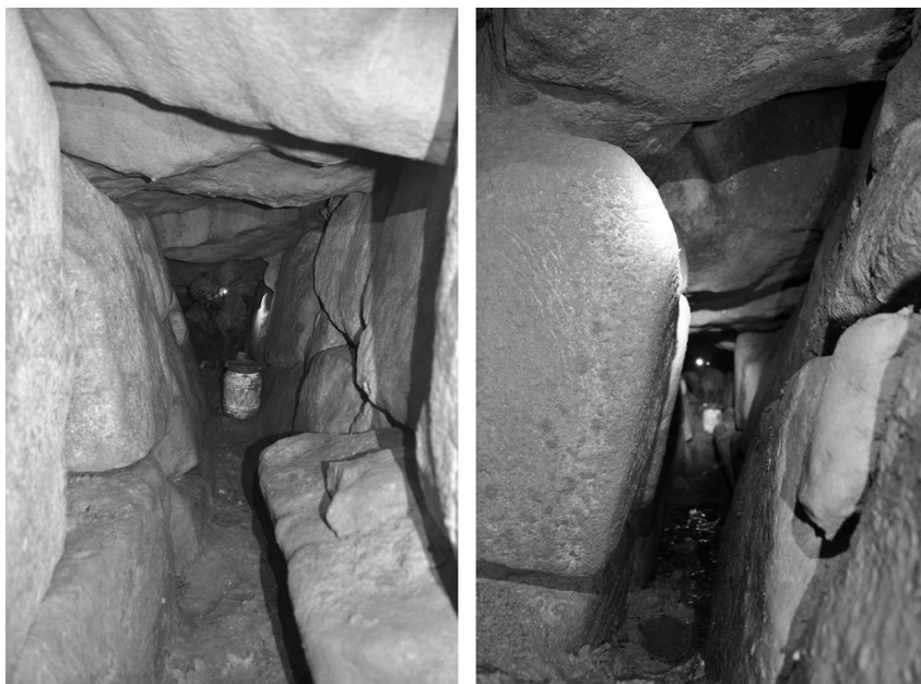
Fig. 29. Collecteur nord : rétrécissement à une trentaine de mètres de l'entrée sur la terrasse.
