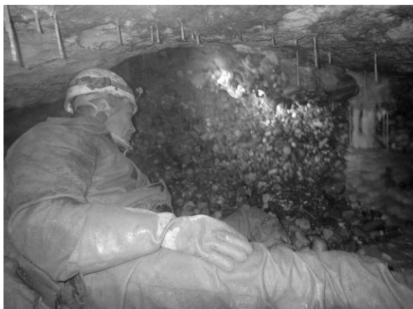
Jean devant le futur chantier.
