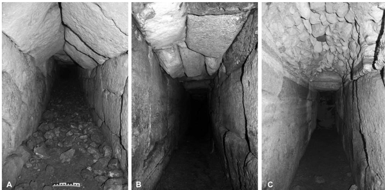
Fig. 22. Exemples de couvertures atypiques. A. Couverture en bâtière dans un diverticule du collecteur principal.
