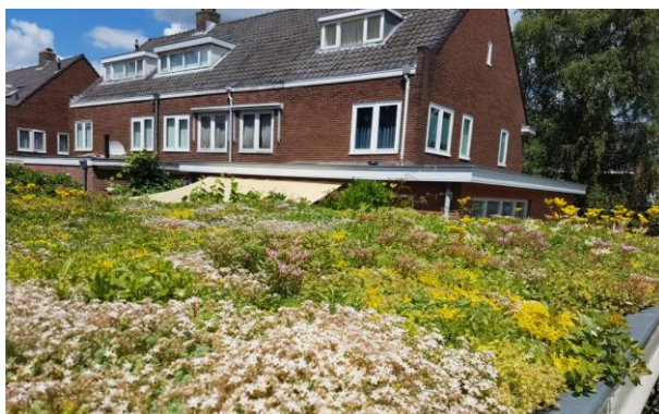
Aangelegd sedumdak door Samen Duurzaam Zeist
