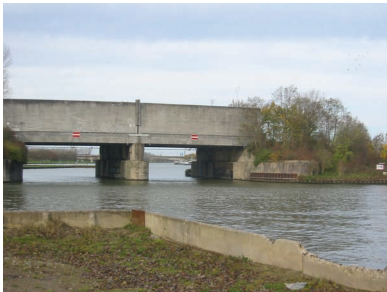
Plofsluis in het Amsterdam-Rijnkanaal
