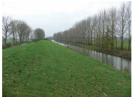
Inundatiekanaal bij Honswijk
