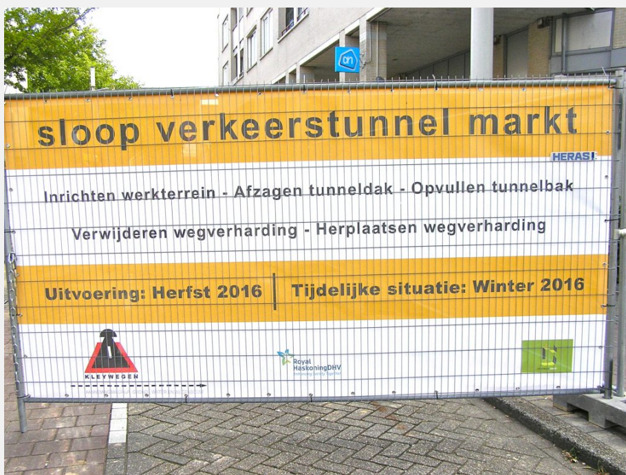
Tijdelijke situatie na de sloop of zo laten?
