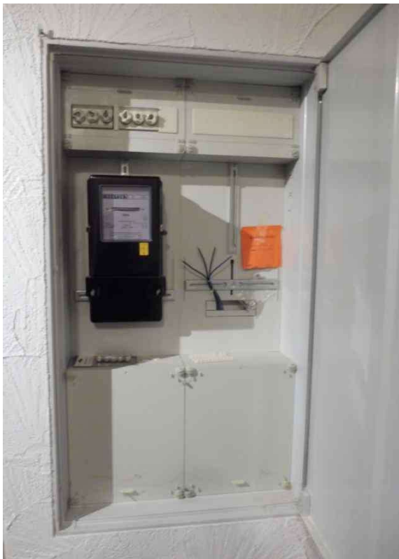
Zählerschrank geöffnet
