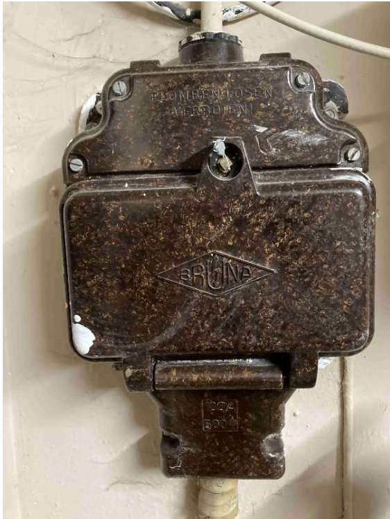
Hausanschlusskasten (HAK)
