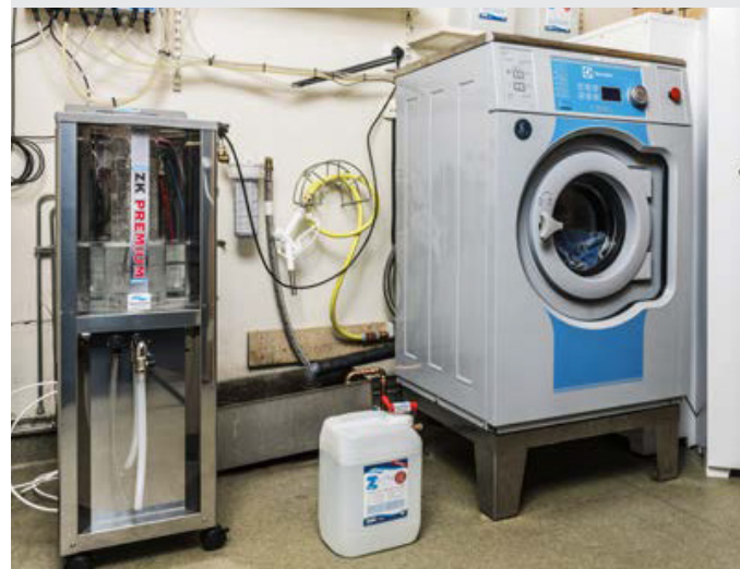
Med nyinstallerade Z-Water Generator och tvättanläggningen klarar man nästan alla tvättbehov utan att använda tvättmedel.
