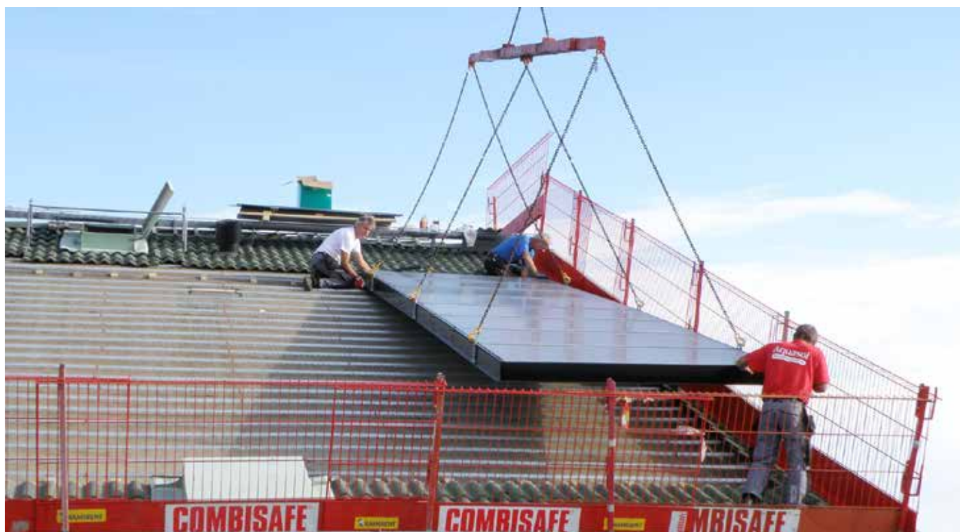
Montageteamet har förberett med monteringskena och en BIG 17 AR solfångare monteras på plats på några få minuter.
