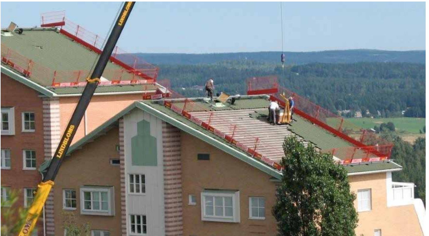
Demontering av takteget där solfångarna skall monteras.
