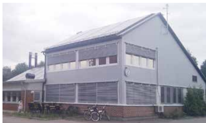
En av Heat-On's referensanläggningar - Sjöstadsverken i Karlstad.
