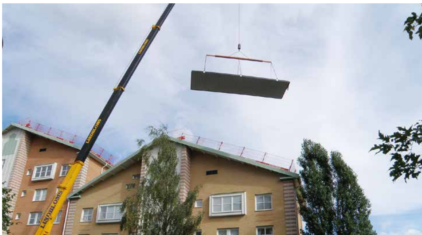
Solfångarna lyfts upp med kran sedan befintligt tegel plockats bort.
