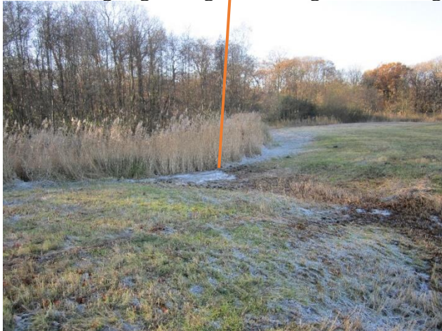
Ondiepe recent aangelegde waterloop
