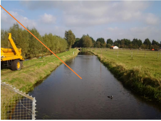
Vanaf Kokshornlaanbrug noordrichting
