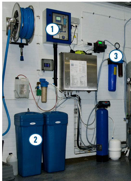
Anolytechs system som producerar AnoDes på plats består av en styrenhet monterad på väggen (1), behållare med salt (2) och en blandningsmodul (3). Bilden visar en standardinstallation.
