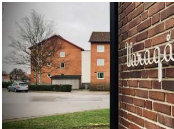
De tre äldreboenden Bjuvs kommun driver i egen regi är samtliga byggda på 60-talet med ett omfattande underhållsbehov.
