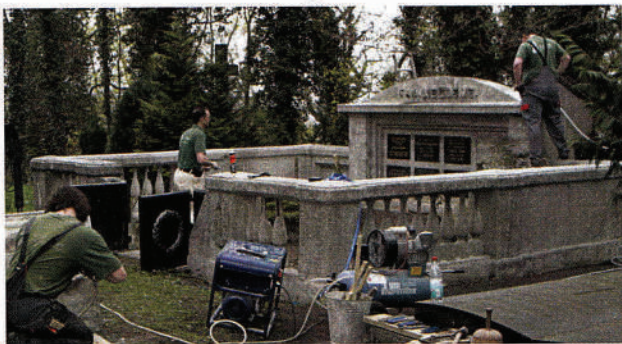
Restaurierungsarbeiten an der Grabanlage Clewe. Fotos: L. Dettmann.
