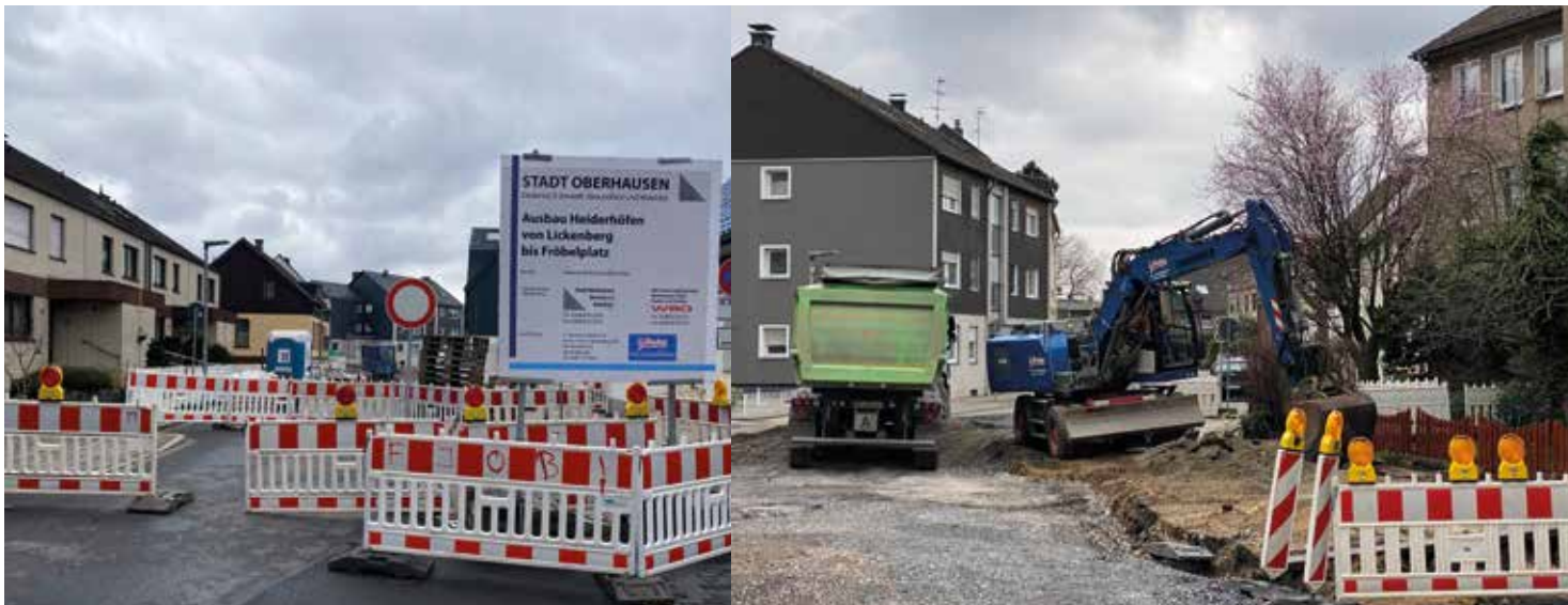
Für die Maßnahme Heiderhöfen wird wohl die Stichtagsregelung nach dem 1. Januar 2018 zum Tragen kommen. Foto: Peter Klunk
