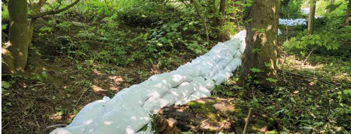
Während des Hochwassers sollten die Sandsäcke den Fuß des Deiches stabilisieren. Foto: Peter Klunk
