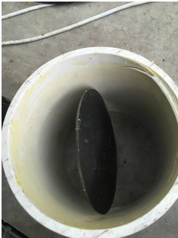
Ny botten monteras i varmt rör
