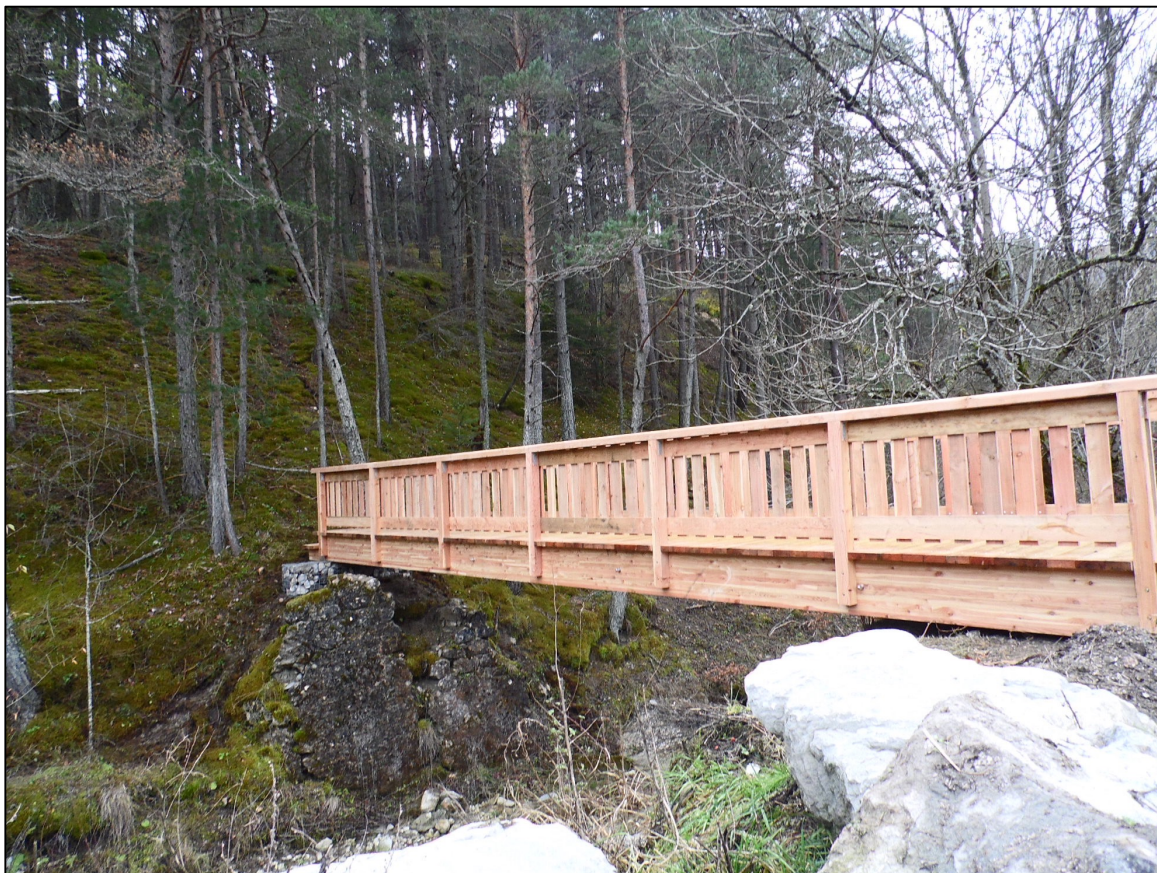
Nouveau pont sur l'Ivoire vers l'ancien accès, on voit encore les piles de l'ancien pont.
