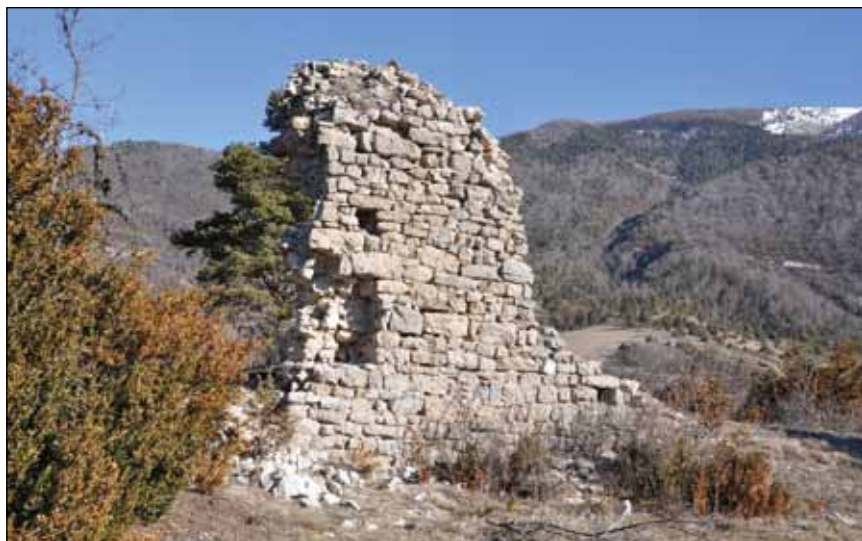
Fig. 4 – Mur médiéval d'un bâtiment de l'ancien castrum de Vauclause, photographié depuis le Sud en 2011, soit de l'intérieur du site castral. © Catherine Planterose.
