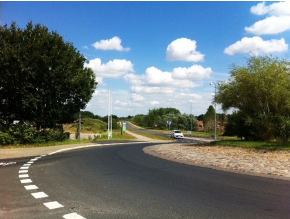
Eksisterende rundkørsel med kig hen ad Nordre Højmarksvej
