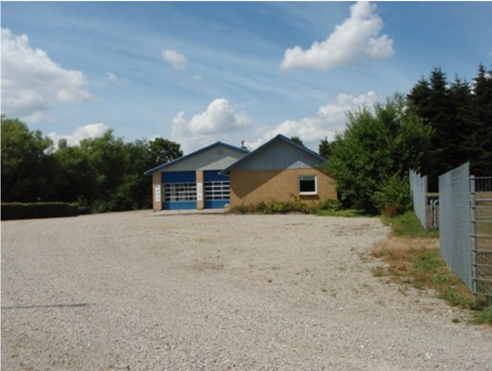
Eksisterende stuehus, værksteds- og lagerbygninger lige syd for lokalplanområdet
