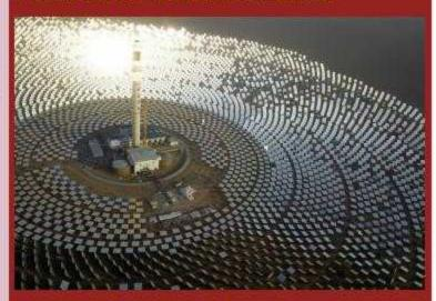
Au sommet de la tour, des fluides contenant des sels fondus permettent de stocker l'énergie solaire. Il y en a tant, qu'une centrale solaire à concentration comme celle de Dunhuang, dans le désert de Gobi en Chine, peut fonctionner la nuit.
