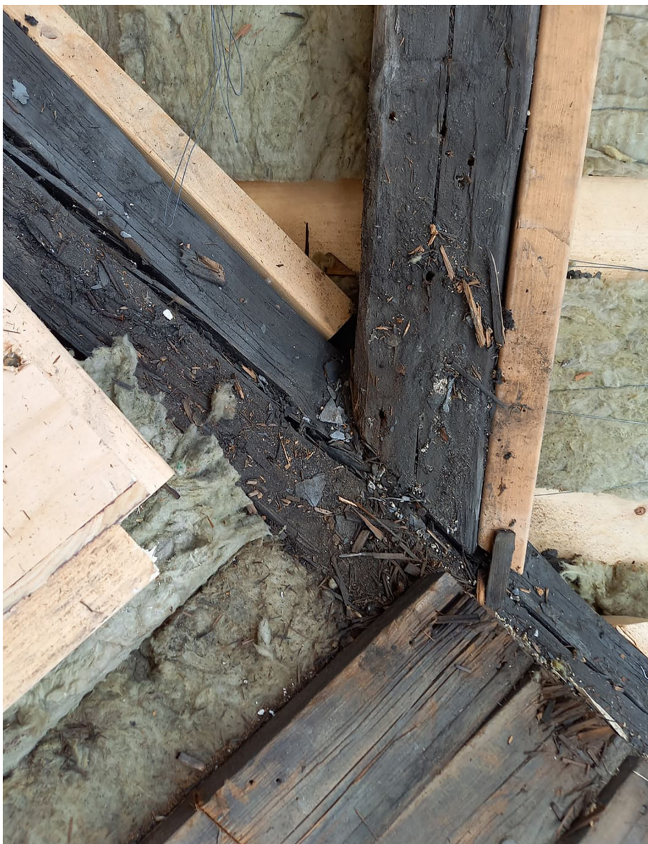
Tagplader, der blev indsendt og bekræftet asbestholdigt. Privatfoto.
