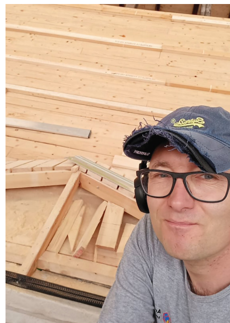
Rikki Hansen arbejdede på et tag med asbest uden beskyttelse.
