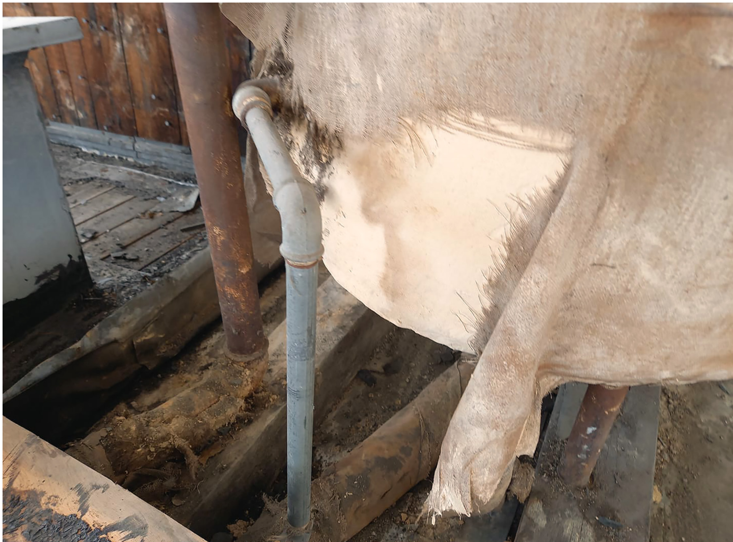
Ekspansionstank med asbestholdigt kiselgur, juli 2021. Privatfoto.
