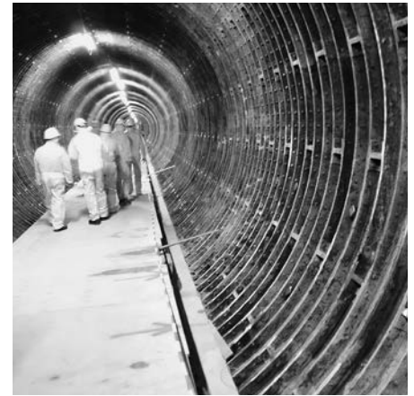
Nach der Entfernung der Verkleidung im alten Elbtunnel während der Sanierung sah man die alten Tübbinge
