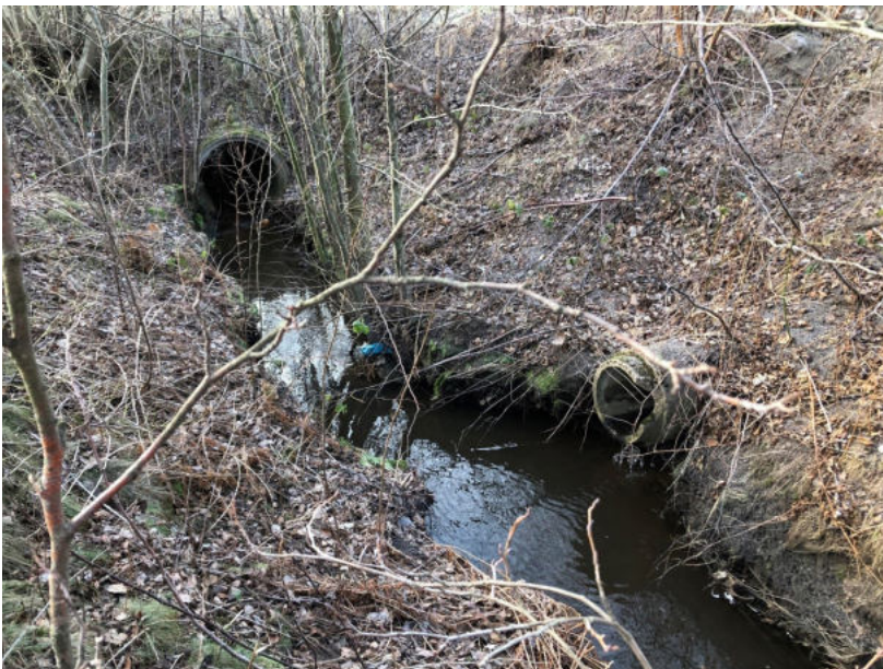
Foton ovan: Bäck Foto till vänster: Dagvattenutlopp till bäck från nedstigningsbrunn (provpunkt nummer 3).
