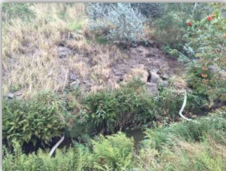
Bild 23. Tre länsar efter varandra som har till syfte att ta upp olja och tungmetaller.
