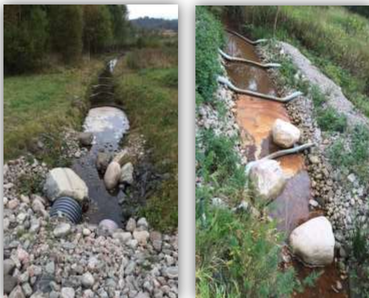
Bild 19 och 20. Utloppskanalen, fyra länsor efter varandra med några meters mellanrum.
