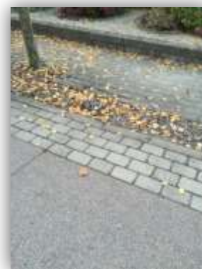
Bild 4. Dräneringsstråk i Mariastaden. Vattnet leds via dräneringsstråk till utjämningsdammar.
