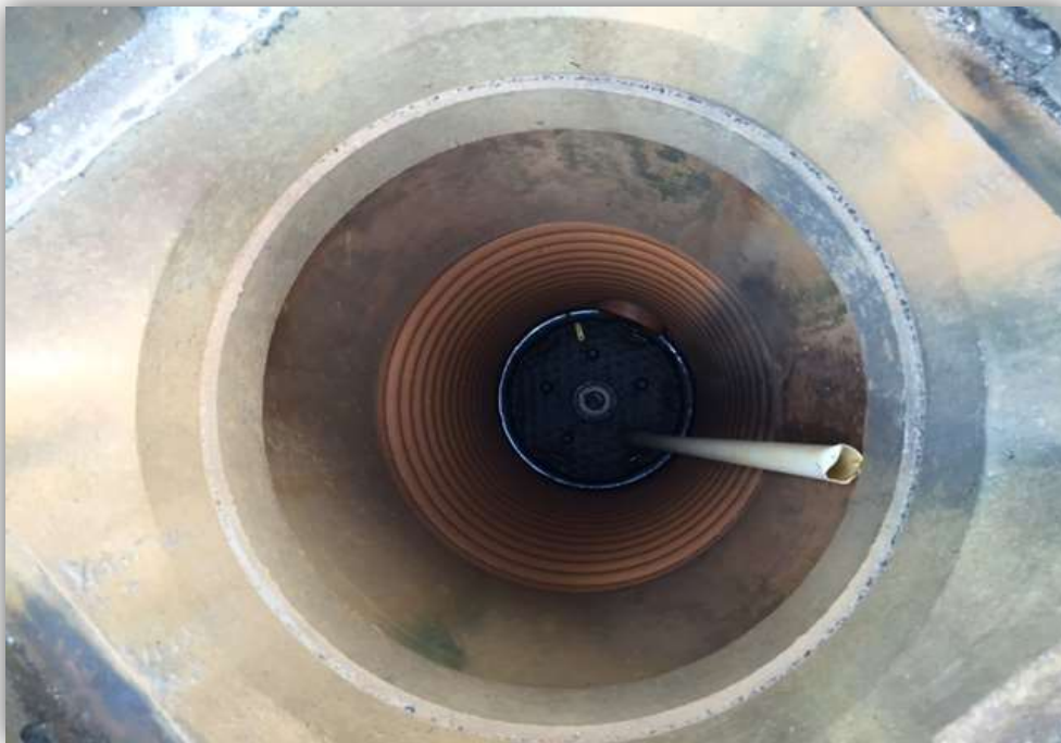
Bild 17. Oljefilter i en dagvattenbrunn
