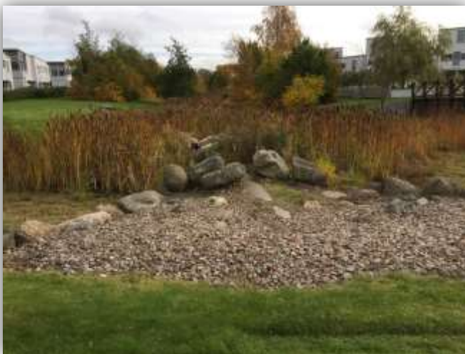
Bild 11 Utlopp från slutdammen. Större sten minskar flödet.
