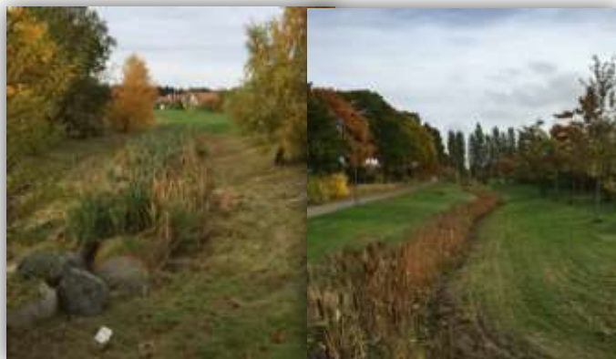
Bild 5 och 6. Svackdiken i Mariastaden. Vattnet leds via svackdiken till utjämningsdammar.
