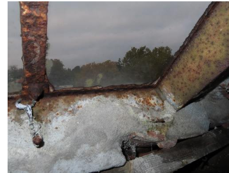
Tagvindue med tærringer
