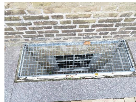
Ydervægge i murværk går ned under terræn
