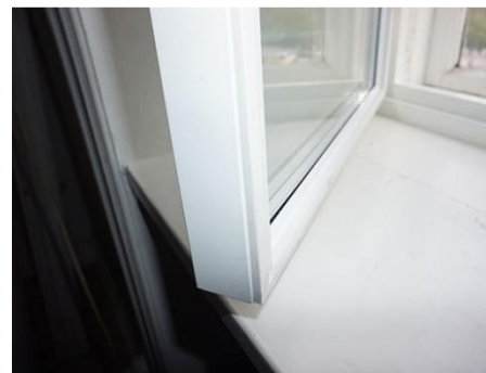
Eksempel på lyd-dæmpende forsatsvindue med aluminiumsramme
