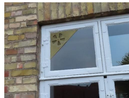
Ventilationsrist i vinduesglas
