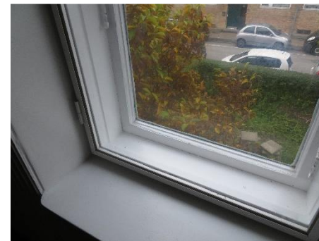
Nyere forsatsvin- due med alumini- umsramme
