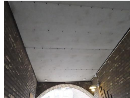
Loft i port fra På Bjerget 2A med loftbeklædning
