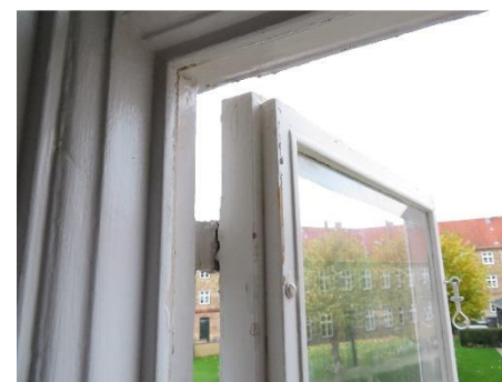
Koblet ramme på eksisterende vin- due
