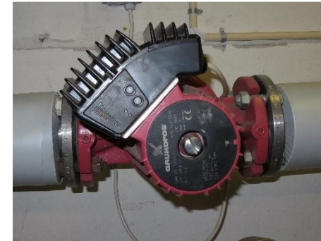
Ældre cirkulationspumpe
