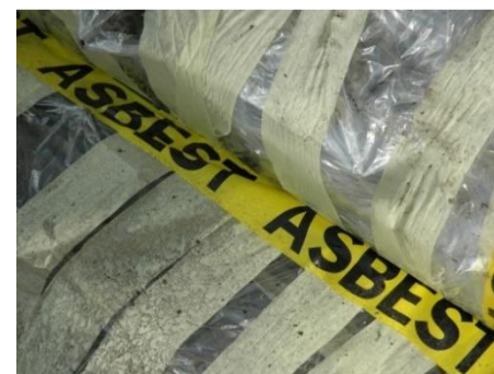
Asbest er et sundhedsskadeligt materiale som blandt andet blev brugt i rørisolering frem til 1972
