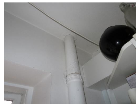
Delvis udskiftet faldstamme i køkken
