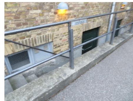
Rækværk på udvendig kældertrappe med afstivede sceptre
