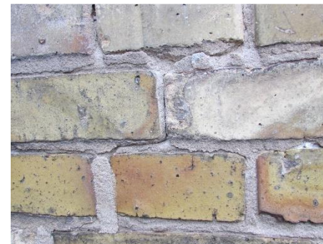
Udvaskede og reparerede fuger
