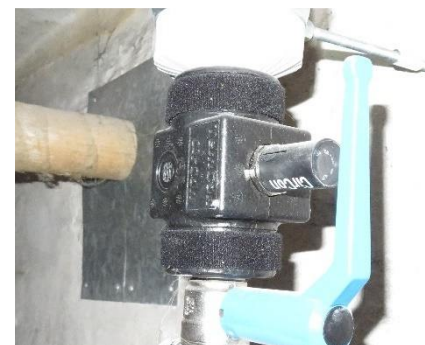
Termostatstyret cirkulationsventil
