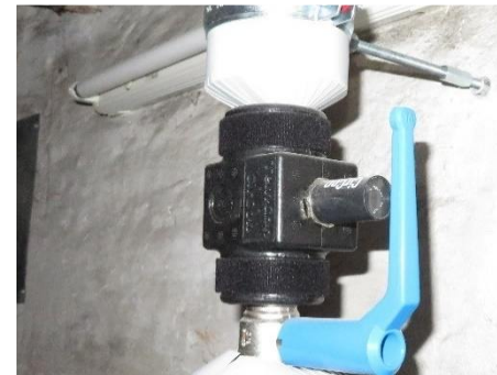
Termostatstyret cirkulationsventil
