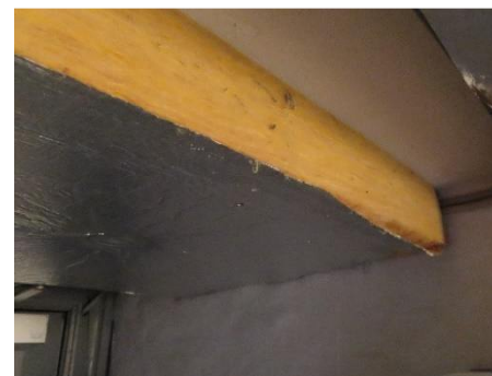
Eksempel på loftisolering af kælder
