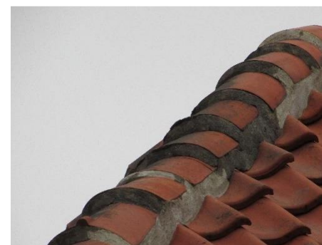
Rygningssten over grat (skråt hjørne)
