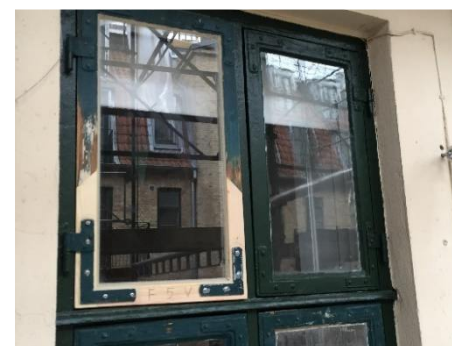
Eksempel på istandsættelse af oprindeligt vindue med udskiftning af defekte trædele
