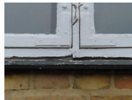
Skader på bundkarm
