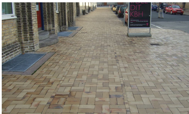
Belægninger på Bispebjerg Torv.
