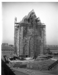
Grundtvigs Kirke under opførelse.
