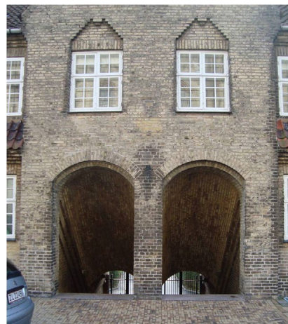
Porte med adgang fra På Bjerget til C.J. Birkedalsvej – bemærk murdekorationer over vinduerne og de murede buer i portene.
