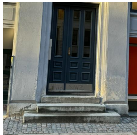
Foto viser eksempel på indgangsparti med pudsafskalninger.
