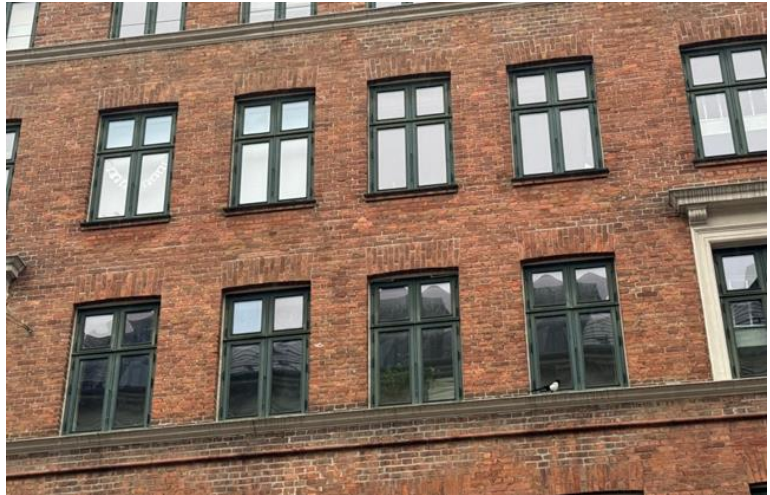
Vinduer vil blive malet og renoveret efter behov.
